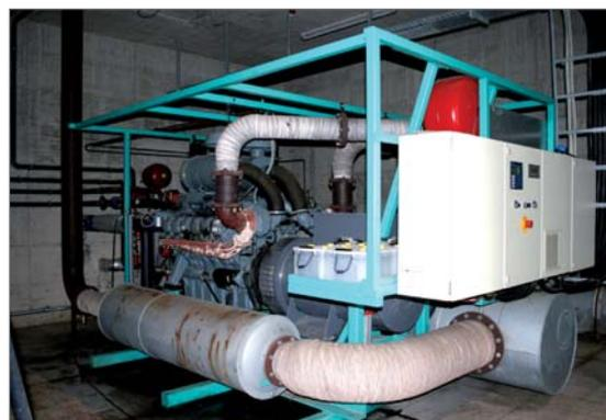
Bild 14 | Blockheizkraftwerk
