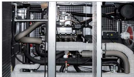
Bild 12 | Blockheizkraftwerk in der Deichwelle Neuwied
