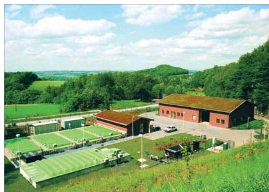
Bild 2 | Deponiesickerwasserreinigungsanlage (DSRA) Fernthal
